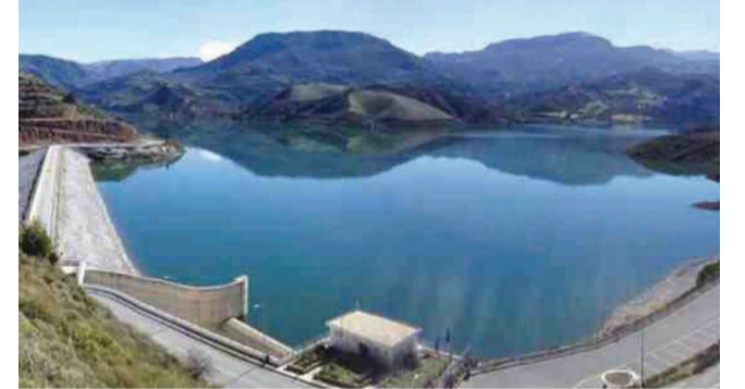
Υβριδικός Σταθμός Αμαρίου
