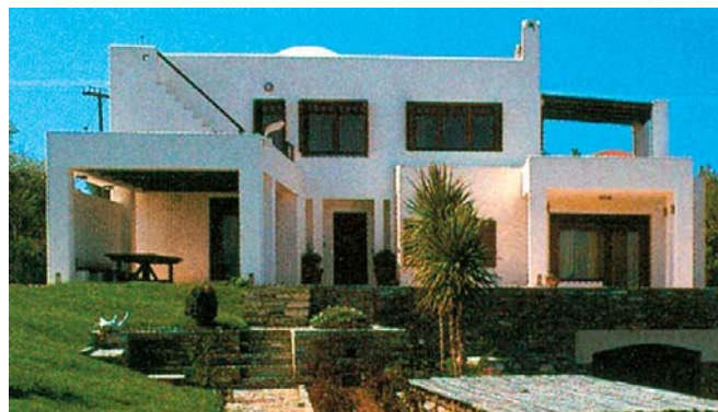
Σήμερα στην Ελλάδα λειτουργούν πολλά κτίρια, με έξυπνες ηλεκτρικές εγκαταστάσεις με τεχνική Konnex.
